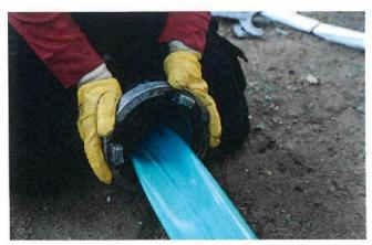
Das Mr. Pipe®-Liner Schlauchlinerverfahren ist für alle Hausanschlussleitungen (Abwasser und Regenwasser) geeignet – unter anderen bei Wurzeleinwüchsen, Scherbenbildung oder fehlenden Scherben, Rissen sowie verschobenen Verbindungen. Ergänzt wird das Verfahren durch den ebenfalls DIBt-zugelassenen Mr. Pipe®-Stretch-Liner für die Sanierung von Leitungen mit drei verschiedenen Dimensionen/Nennweiten.
